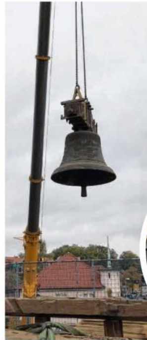
Die 1763 in Celle gegossene Glocke wird aus dem hölzernen Glockenstuhl der St.-Lamberti-Kirche herausgehoben. Bevor die Bronze-Glocke auf den Lkw geladen wird, trennt Jürgen Schwarck (oben rechts) den Klöppel ab.
