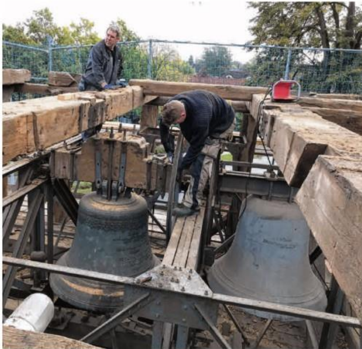
Die 1763 in Celle gegossene Glocke wird aus dem hölzernen Glockenstuhl der St.-Lamberti-Kirche herausgehoben. Bevor die Bronze-Glocke auf den Lkw geladen wird, trennt Jürgen Schwarck (oben rechts) den Klöppel ab.
