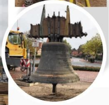
Die 1763 in Celle gegossene Glocke wird aus dem hölzernen Glockenstuhl der St.-Lamberti-Kirche herausgehoben. Bevor die Bronze-Glocke auf den Lkw geladen wird, trennt Jürgen Schwarck (oben rechts) den Klöppel ab.
